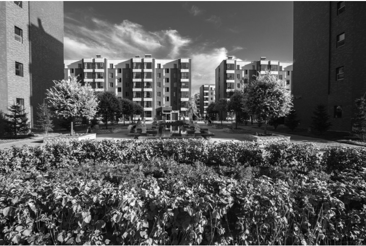
高档住宅小区
