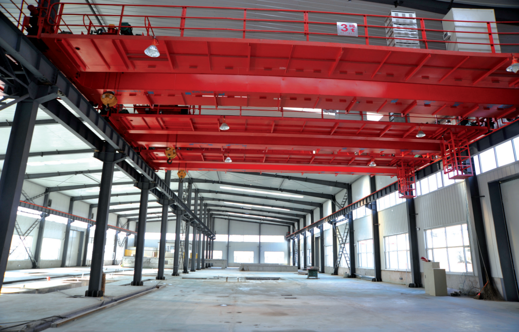
落户于洮北区经开区的高新材料项目高性能磨球生产基地一期基建工程目前已接近尾声,该项目由白城市北奥新材料科技有限公司投资建设,总投资9.5亿元,分三期建设。项目一期厂房、变电站主体完工,设备基础和厂房地面已完工,正处于设备安装阶段,年末可完成设备安装及调试,2015年初投产运行,预计年实现产值2亿元,实现利润1200万元。
