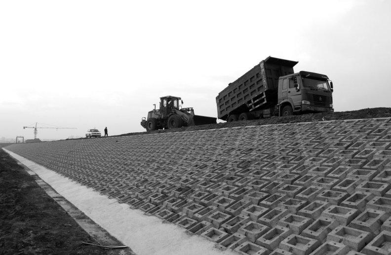
为防范洪灾，镇赉县积极开展水毁工程建设，筹措资金3500万元，在确保质量的前提下，合理抢抓工期。截至目前，已完成月亮泡水堤混凝土铰接板块护坡2.7公里，新建的月亮泡排灌站也完成了总工程量的35%。
