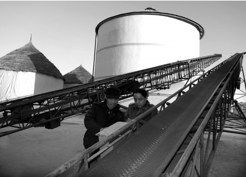
秋粮收购即将开始，镇赉已完成收购前的准备工作。目前已备好35万吨仓容，完成700余台套的粮食机械维修，对收储企业的消防设施进行了全面检查验收，为保护种粮农民利益、规范收储秩序，该县粮商局还加强了执法人员的培训，配备了执法所需的设备。图为镇赉县第一粮库机修工人在检查粮食输送机。
