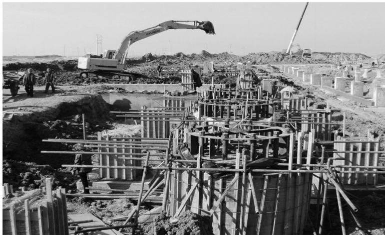
落户于两家子工业园区的煤焦油轻质化项目一期工程抢抓工期,加快推进。目前所有装置区设备基础构架及管廊基础已完成。 刘立秋摄
