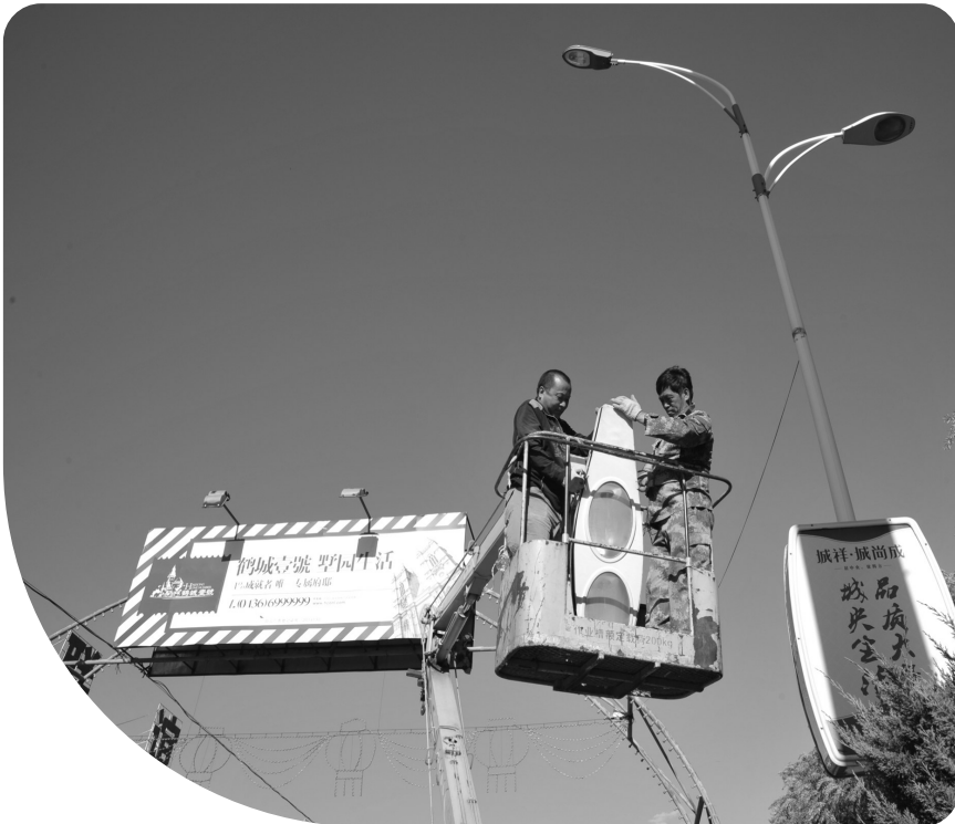
为进一步完善城市功能,优化市民生活、出行环境,洮北区全面实施辖区老旧路灯升级改造工程,更换路灯2748套,结束了明仁南北街和九一三路夜间无路灯照明的历史。图为路灯维修人员正在拆卸破损的路灯。孙文涛摄
