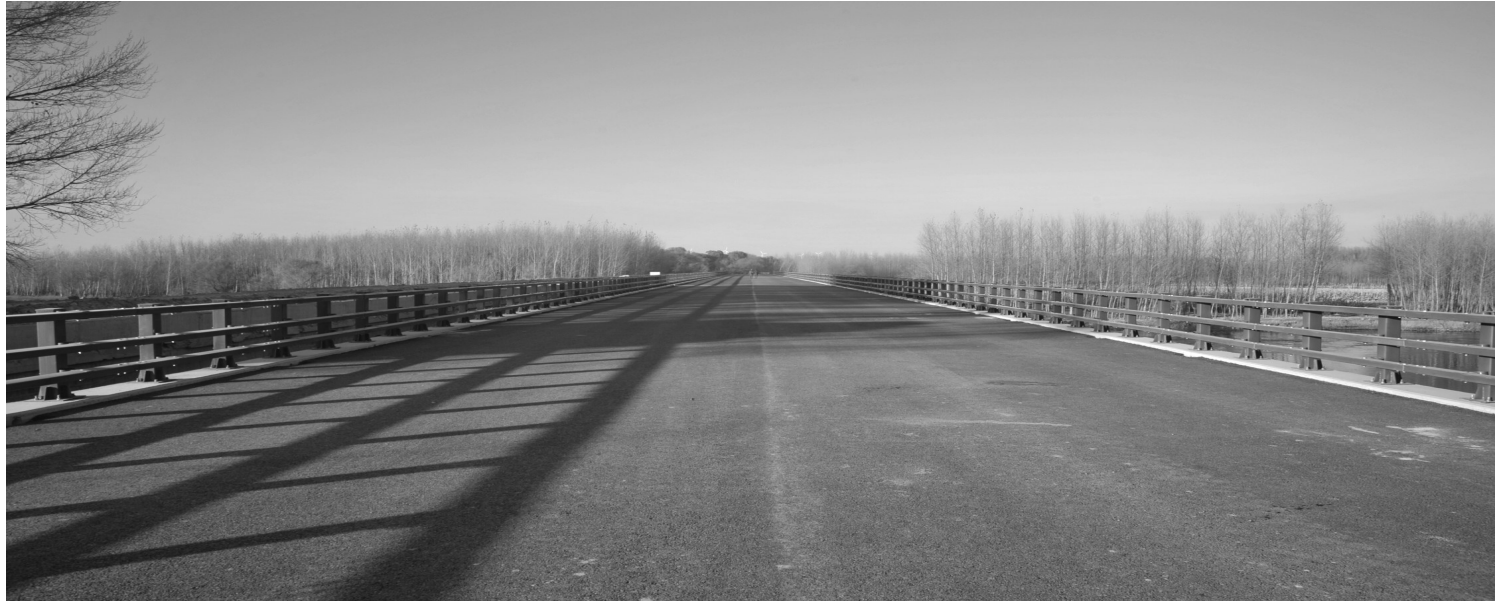
2014年,洮北区加大交通条件改善工作,其中市区至洮河镇二级公路已启动建设,新建农村等级公路51公里。图为已经全面竣工的半拉山大桥主桥。孙文涛摄
