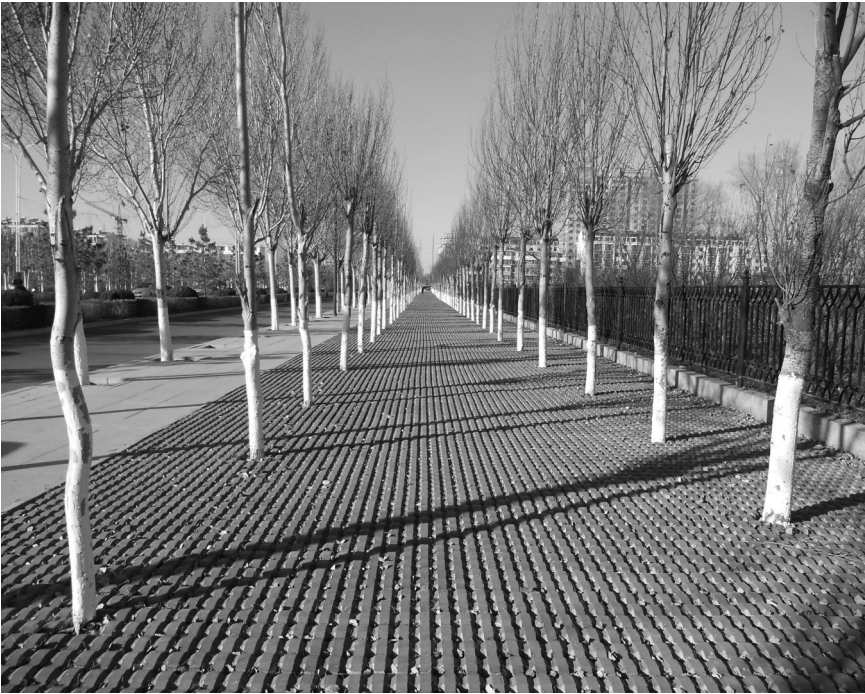
2014年，白城经开区积极落实民生实事，全力推进基础设施建设，城区环境大幅改善。图为硬化铺装完毕后的光明街。
