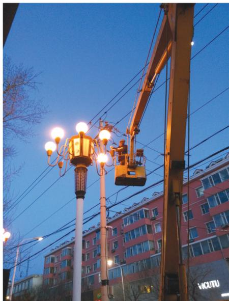
为了保障市民夜间出行安全,营造春节喜庆气氛,近日,白城市市政维护管理处的维护人员日夜巡查,修旧换新,让受损的路灯尽快恢复正常照明。图为维护人员在更换破损的灯泡。 孙文涛摄
