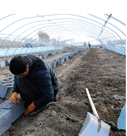
农民进行着覆盖棚膜前的最后安装工作。
