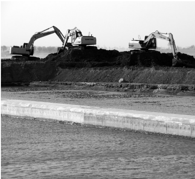
通榆县幸福渠溢流坝清淤工程正在进行，此工程于去年8月开工，今年5月末完工，工程总长度14.08公里。图为清淤现场。
