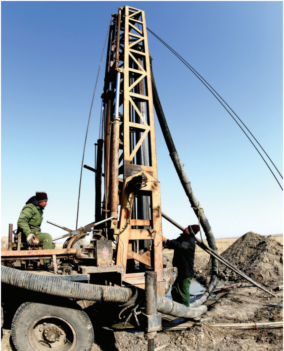
图为打井现场。
