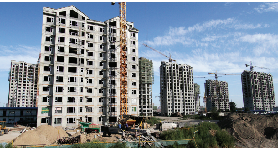
图为生态新区棚户区改造集中回迁区工程建设现场。
