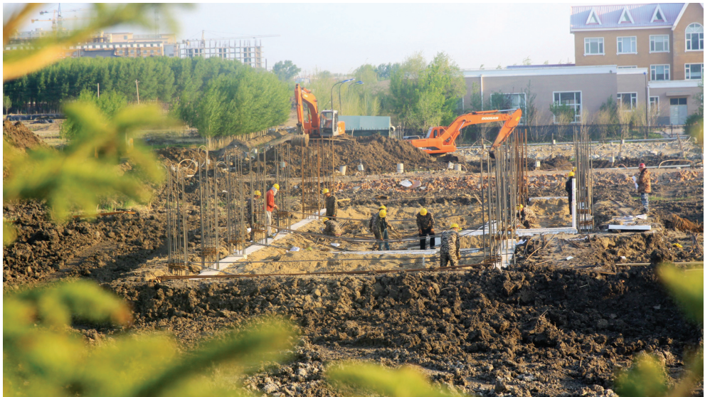
今年,大安市共实施3000万元以上重点项目48个。目前已有21个3000万元以上重点项目开工、复工,其中亿元以上项目19个。图为正在建设中的污水处理场二期。
