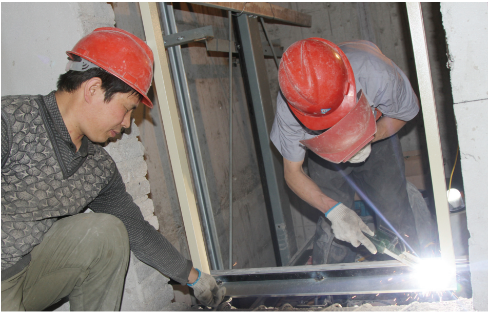
因为工人正在安装电梯。
