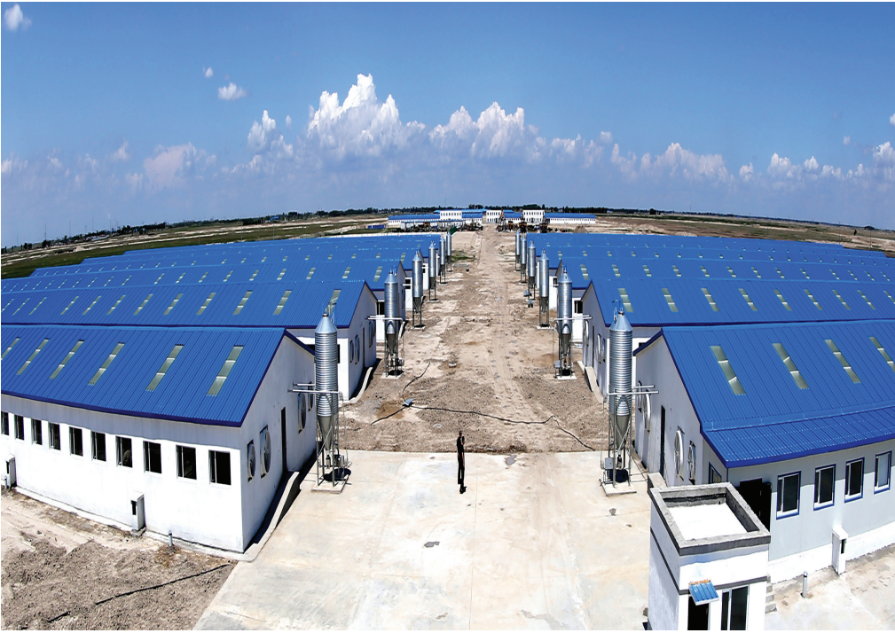
洮南市雏鹰农牧有限公司年出栏400万头生猪一体化项目,集生猪养殖、饲料加工、生猪屠宰、熟食加工、有机肥生产、新能源沼气开发利用和冷链物流于一体,目前已完成猪舍214栋、生猪存栏5万余头。
