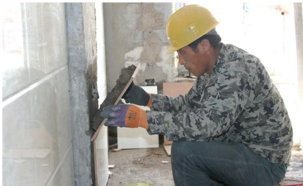
新城家园棚改项目样板间装修工程也已经接近尾声。图为一位工人正在为卫生间墙壁粘贴瓷砖。 本报记者张风文摄
