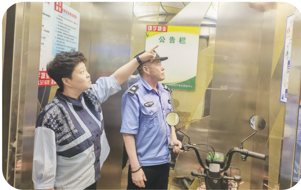
白城经开区幸福街道办事处以花园社区铂金时代小区为试点，坚持技防、人防相结合，携手环宇物业公司，共同为小区电梯加装阻车器，通过自动识别和感应，有效阻止电动自行车进入电梯，为小区居民守住了消防安全的“第一道关”。图为工作人员测试安装好的电梯阻车器。
