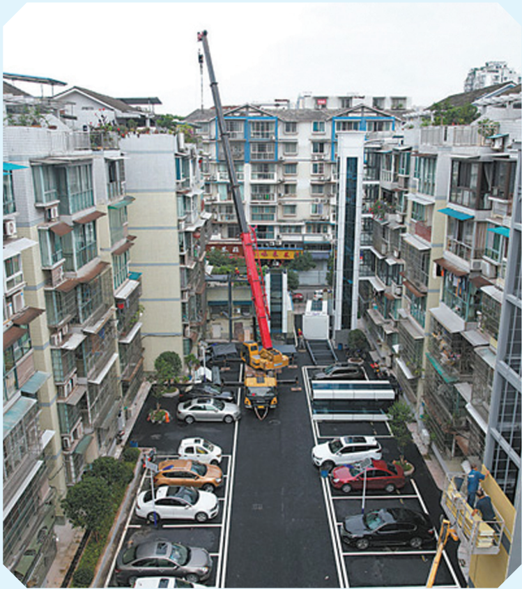
四川省内江市东兴区一老旧小区住宅正在加装电梯。 兰自涛摄(影像中国)
