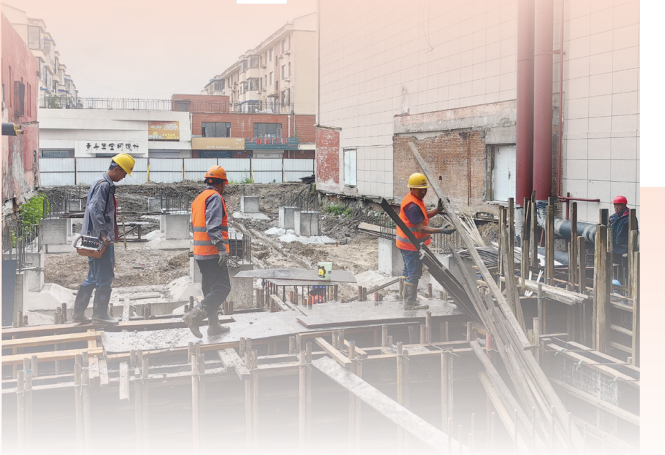
图为施工现场。
