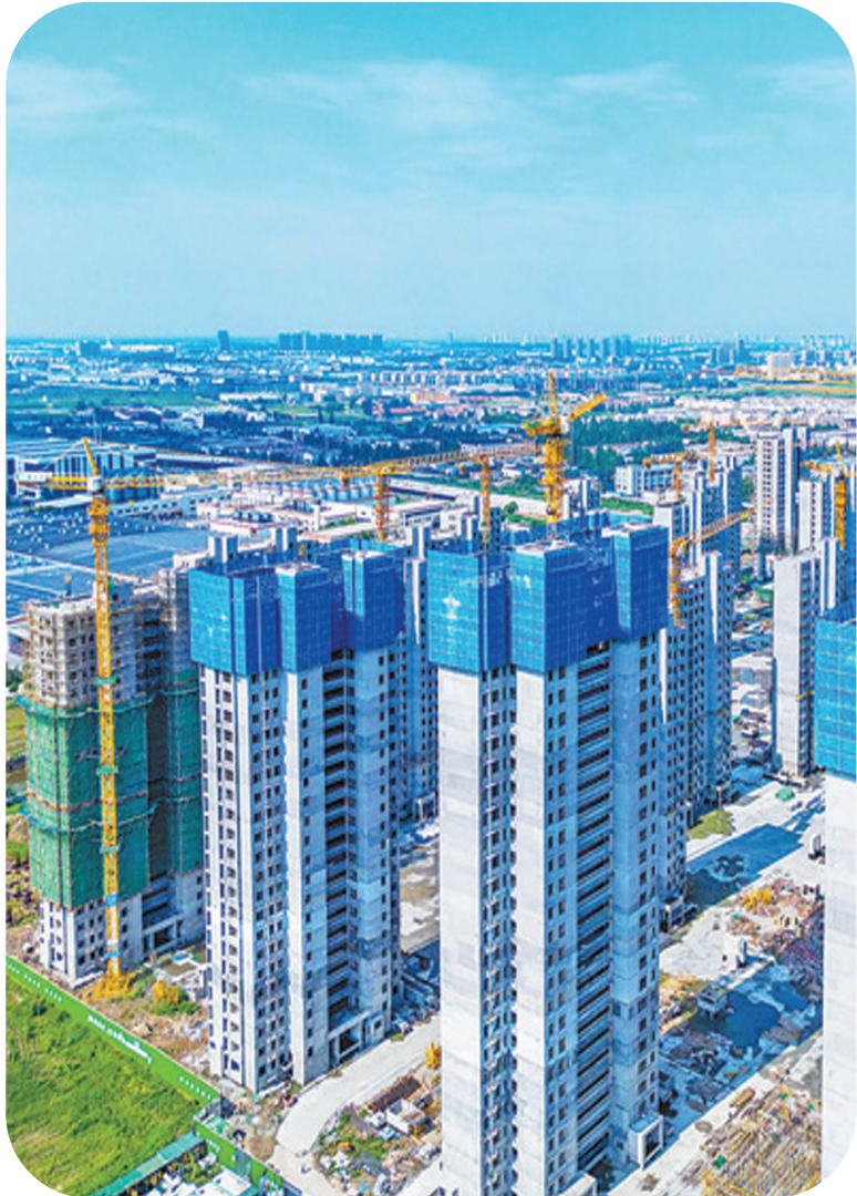
江苏宿迁市宿豫区盛世东城保障性住房工程现场,机械运转,正在施工。王帅甫摄(影像中国)
