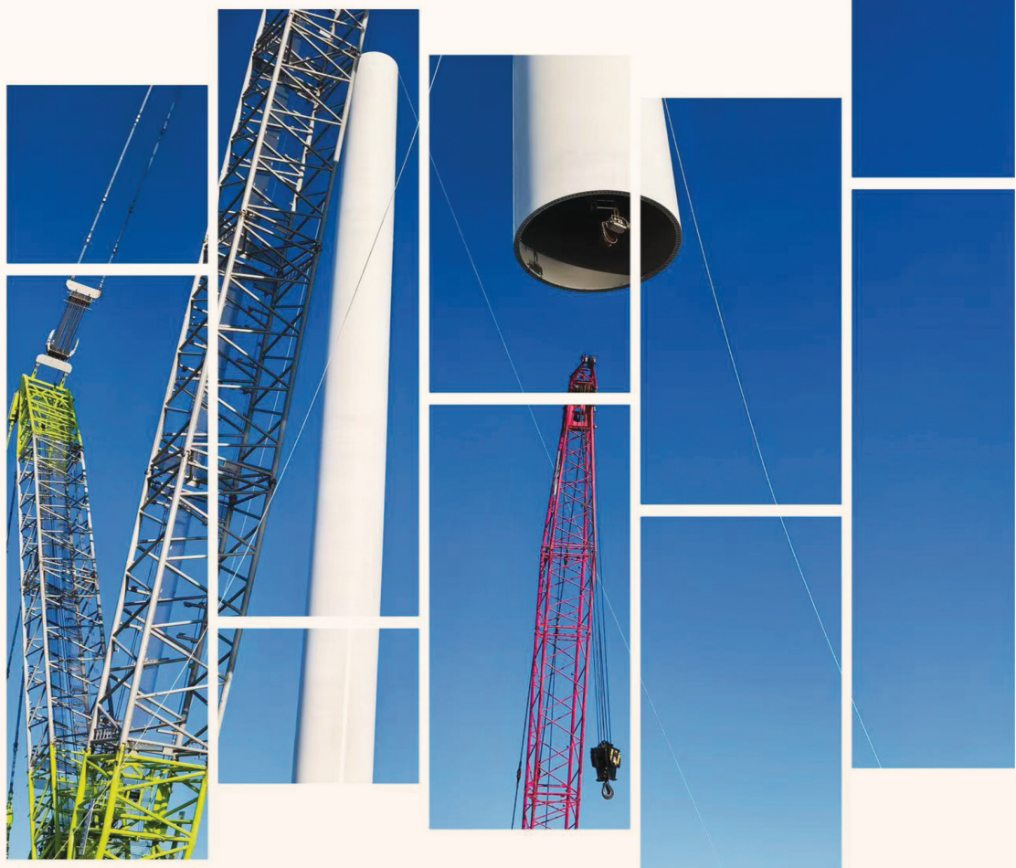
▲通榆风电安装。
