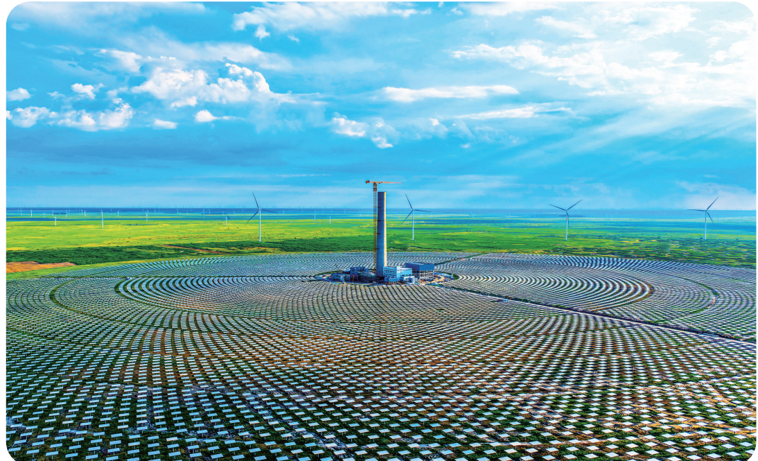
图为项目建设现场，一座“光棱塔”擎天而立，近2万面定日镜分布周围，场面壮观。
