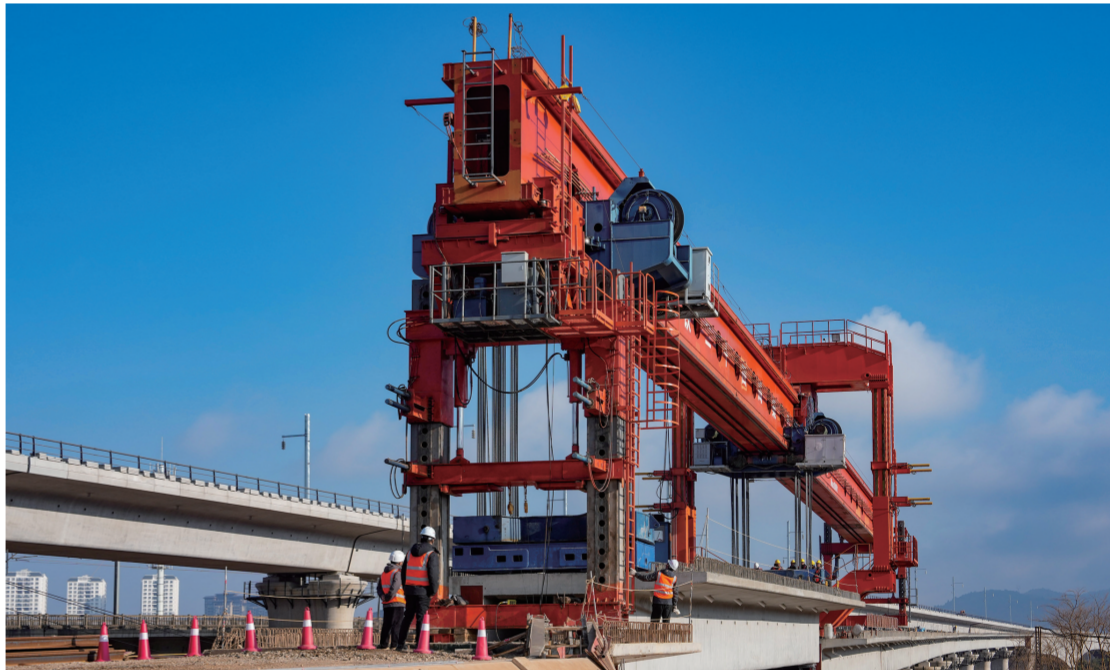
这是2月3日拍摄的渝昆高铁最后一根箱梁架设施工现场。 2月3日上午,在位于云南省昆明市呈贡区的渝昆高铁施工现场,随着最后一根箱梁精准落位,渝昆高铁全线桥梁建设全部完成,为后续铺轨及站后工程施工奠定了坚实基础,标志着渝昆高铁建设进入全面冲刺阶段。 新华社记者陈欣波摄
